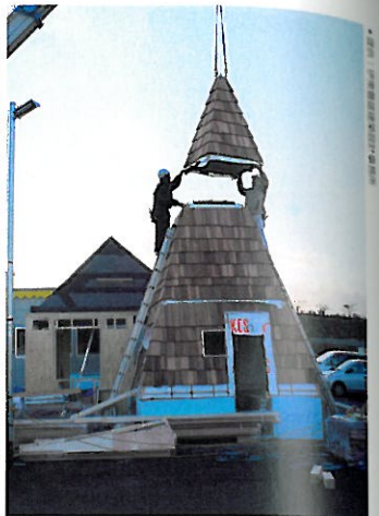
左：仮設住宅の住民と話し合いながら設計を進めた。住民からはそれぞれの家の配置や、隣接するひまわり集会所から室内を見通せるようにといった要望が出た。*中上：テーブルの家の屋根スレートの隅切り作業はボランティアの方がたが担当した。*中下：縁側の前に置くテーブルを住民の方がつくった*。右：工場で施行したパーツを現地で施行している様子。*
