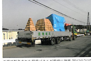
工場で製作された屋根パネルが現場に到着 2012/12/19
