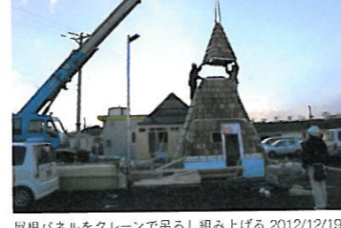
屋根パネルをクレーンで吊りし組み上げる 2012/12/19
